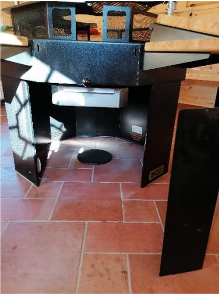
Unter der Feuerfläche befindet sich im Fußboden ein Rohr für die Zuluft. Vor dem Anfeuern muss der schwarze Deckel vom Rohr abgenommen werden. Schließen Sie die Frontabdeckung danach wieder, damit die Zuluft nur zum Feuer gelangt.
